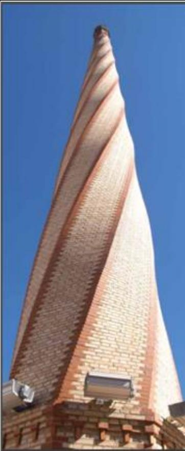
haciendo más estrechas según se van elevando. Cada metro de altura se estrechan cinco centímetros. El grosor de las paredes en la parte baja de las chimeneas es de casi un metro para soportar todo el peso de la chimenea. Según se eleva la chimenea, el grosor de los muros disminuye también. La construcción se hacía por el interior, sin andamiaje externo.
